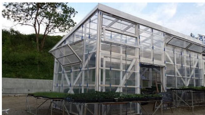
完成した育苗用温室
