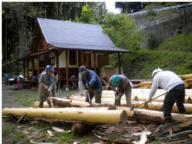
まずは丸太の皮むきから！！
