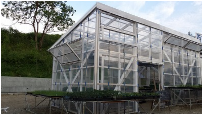
完成した育苗用温室
